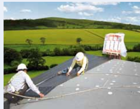
Una fase di applicazione delle membrane ADESO® sul tetto di un capannone industriale
