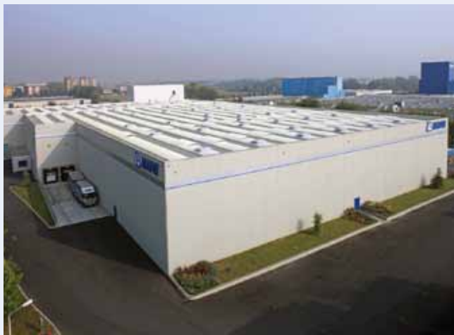
Il nuovo magazzino materie prime e imballi (7500 m 2 con 15000 posti pallet)
